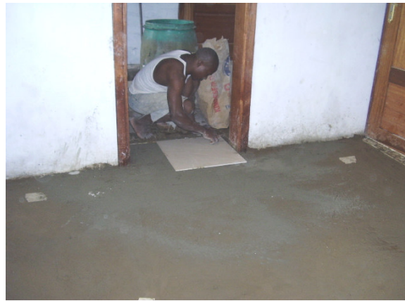
Quelques photos de la pose de carrelage à l'école Acolisa (septembre 2007)
